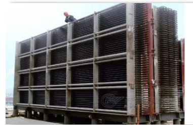
换热器系统中珐琅管的安装
