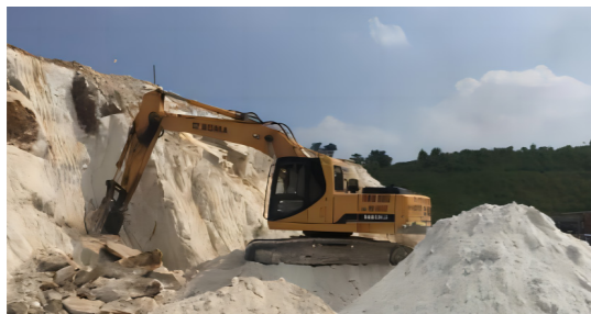
采用改装开采机械对复杂矿体进行精细化开采
