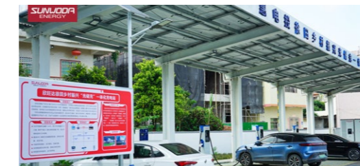
欣旺达徐田乡村振兴“光储充”一体化充电站
