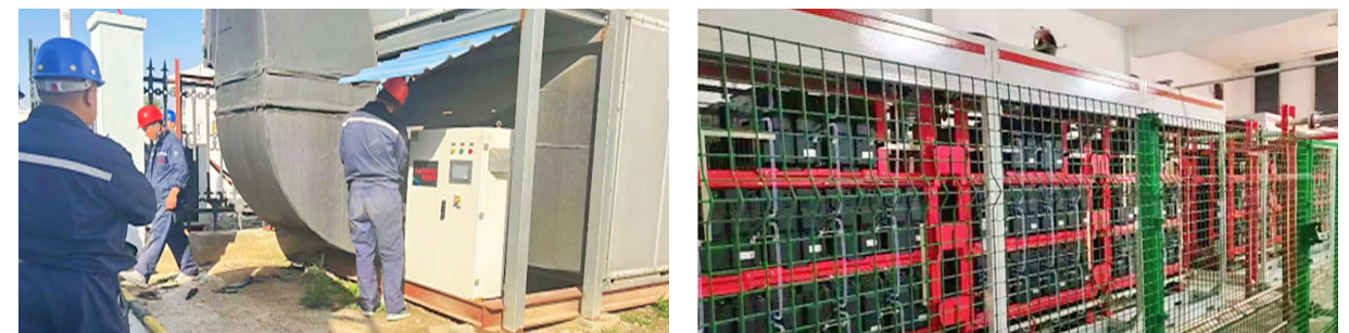
夏津项目动态无功补偿装置改造
