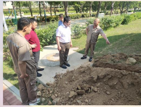
检查现场-园区
