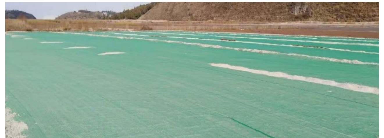
老厂分公司尾矿库干滩铺设防尘网
