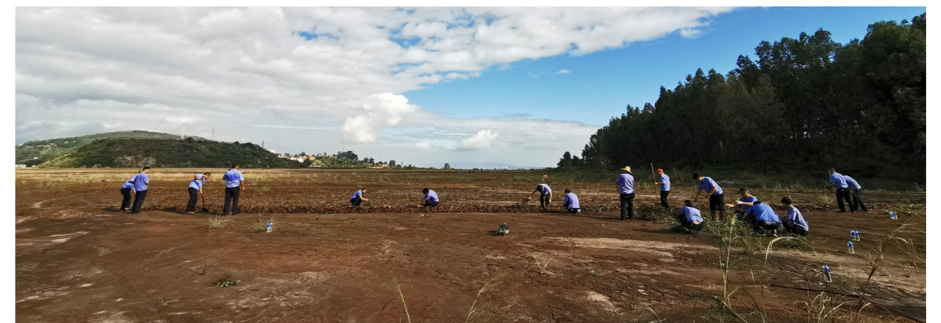
大屯锡矿选矿车间尾矿坝栽种蟛蜞菊
