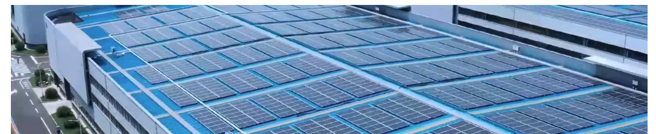
▲江苏海目星屋顶太阳能板
