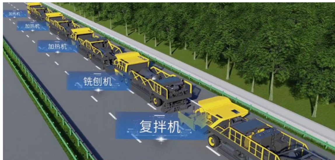
就地热再生施工
