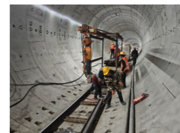
既有成型隧道运输钢轨及风水电铺设
