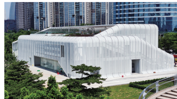
110 千伏猎桥输电工程项目先后获得“广州市建设工程结构优质奖”“广东省建设工程优质结构奖”“广东省建设工程优质奖”“2022 年度中国电力优质工程（中小型）”“2023-2024 年度第一批中国安装工程优质奖”。
