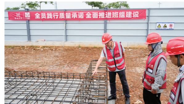
环北部湾广东水资源配置工程施工 D2 标开展质量监督检查
