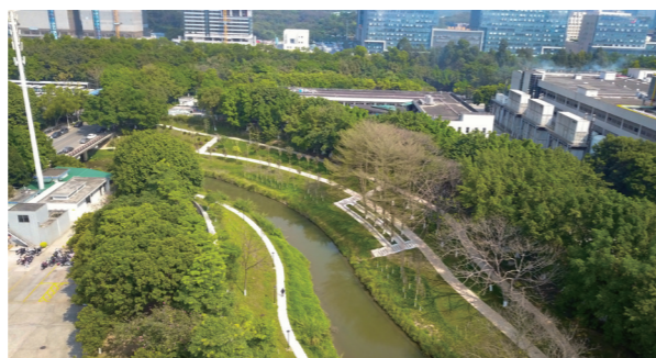
广州市科学城水环境综合提升工程
