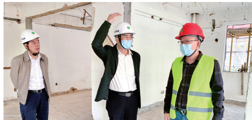
粤建筑装饰领导班子带队到一线项目开展安全生产及重大事故隐患排查整治专项行动督导检查
