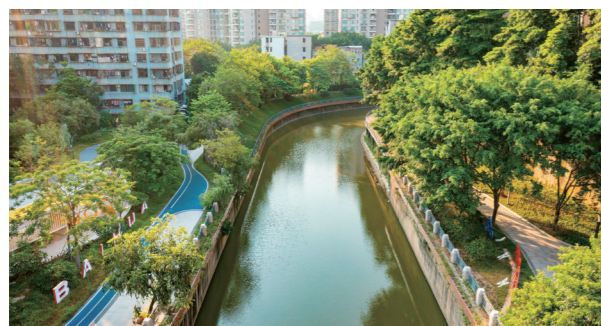
广州市增城区荔城街碧道建设工程
