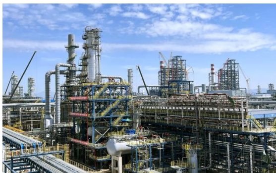
图9：NCC钢结构应用于石油化工领域
