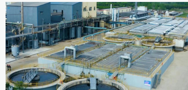
▲ 公司废水处理站
