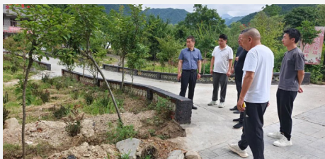
张建德检查华阳第二水源地建设项目进度
