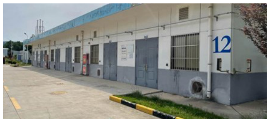
化学品库外部
