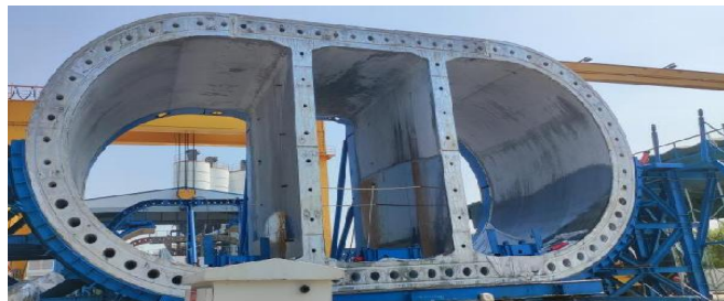
浇筑全球首个大体积薄壁空腔预制构件
