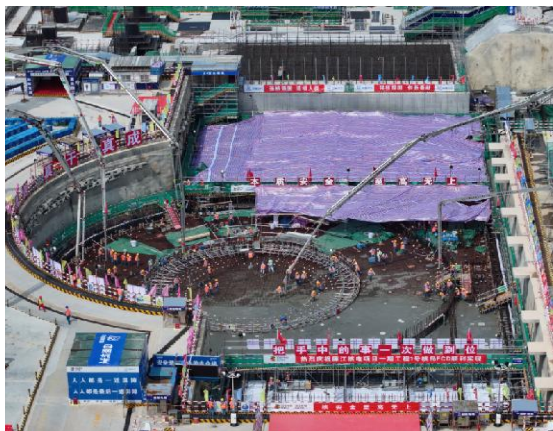
广东廉江核电工程—实现全球同类机组核岛FCD最短浇筑纪录
