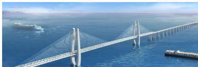
杭州湾跨海大桥—助力世界最长跨海铁路桥承台施工
