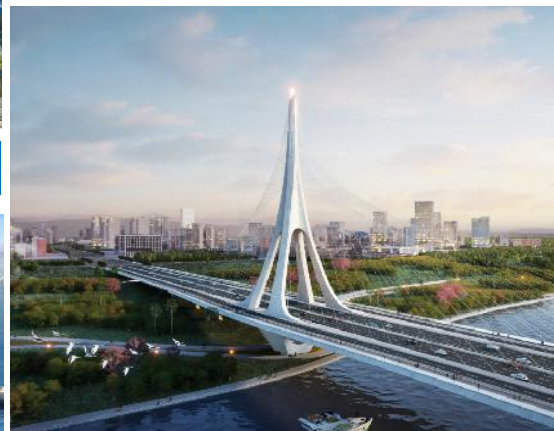
沱江大桥—实现UHPC在世界最宽桥梁主体结构的应用
