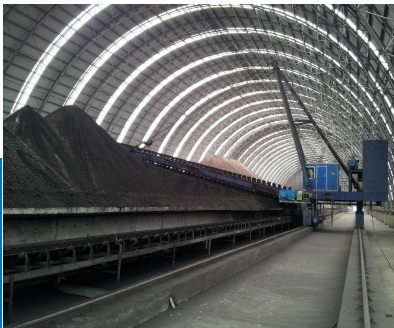
原材料长堆棚均化系统
