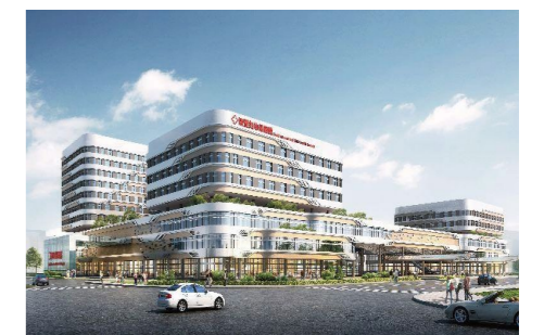
诸暨市妇幼保健院项目
