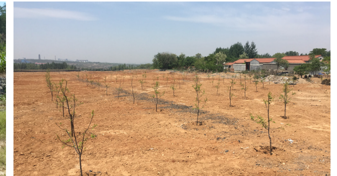
公司下属五阳煤矿矸石填沟造地工程
