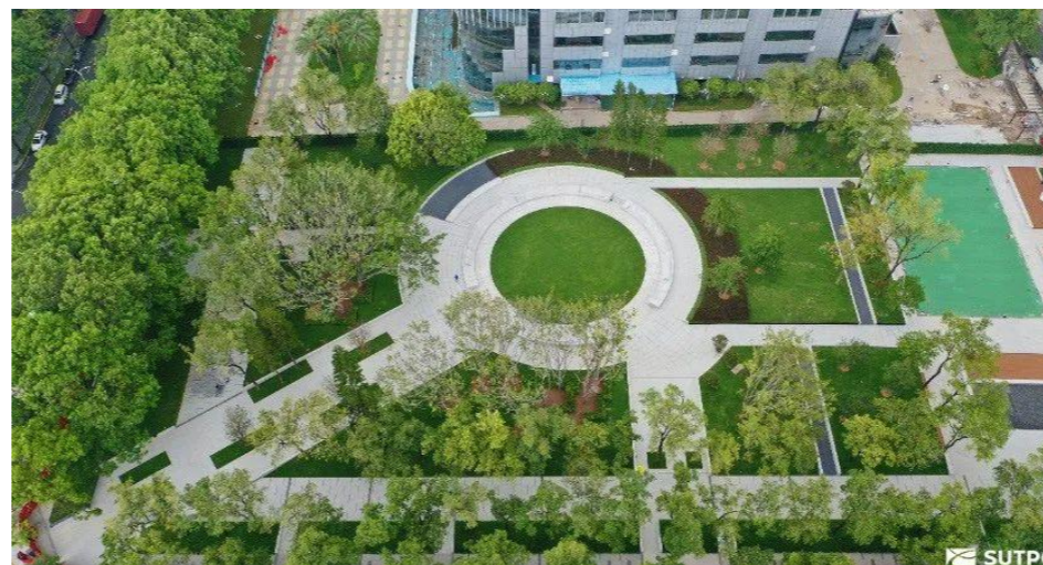
深港科技创新合作区 重要节点功能完善和环境整治工程
