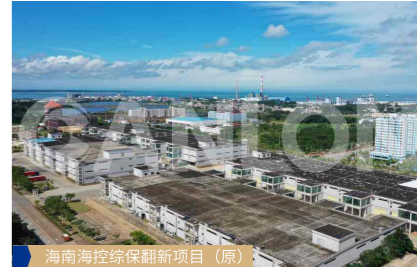
海南海控综保翻新项目(原)
