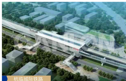
杭临城际铁路
