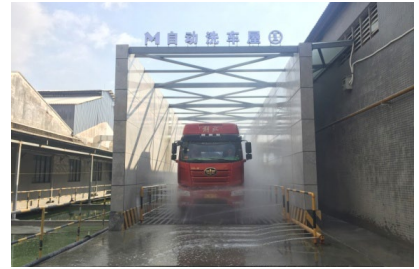
生产区域出入口设置自动洗车设备
