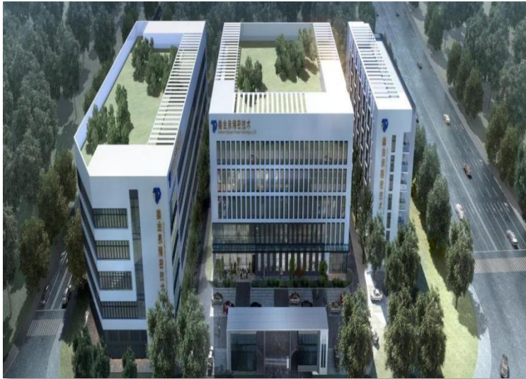
（鑫金泉精密刀具制造中心建设项目（一期）项目）
