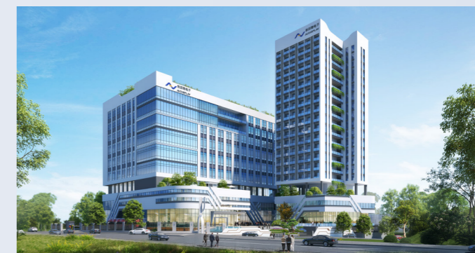
■ 深圳产业基地（建设中）
