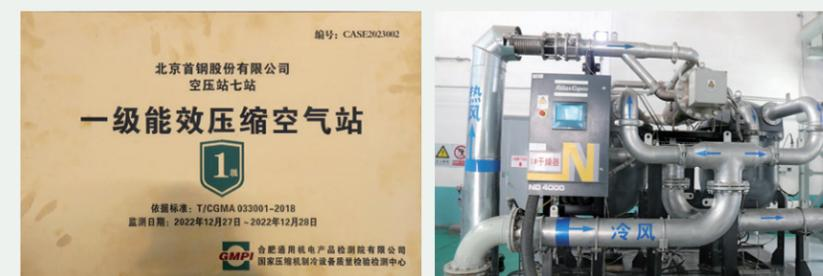
全年节电143万kWh。经过第三方检测机构鉴定，空压机实际输功效率达到58%，超过了一级能效55%的标准线，被中国通用机械工业协会授予“一级能效压缩空气站”，成为全国钢铁行业首个符合一级能效标准的空压机站。
