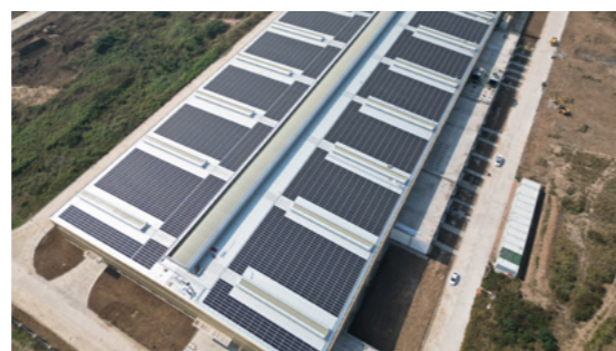
东博盛业 2MW BIPV 屋顶光伏项目
