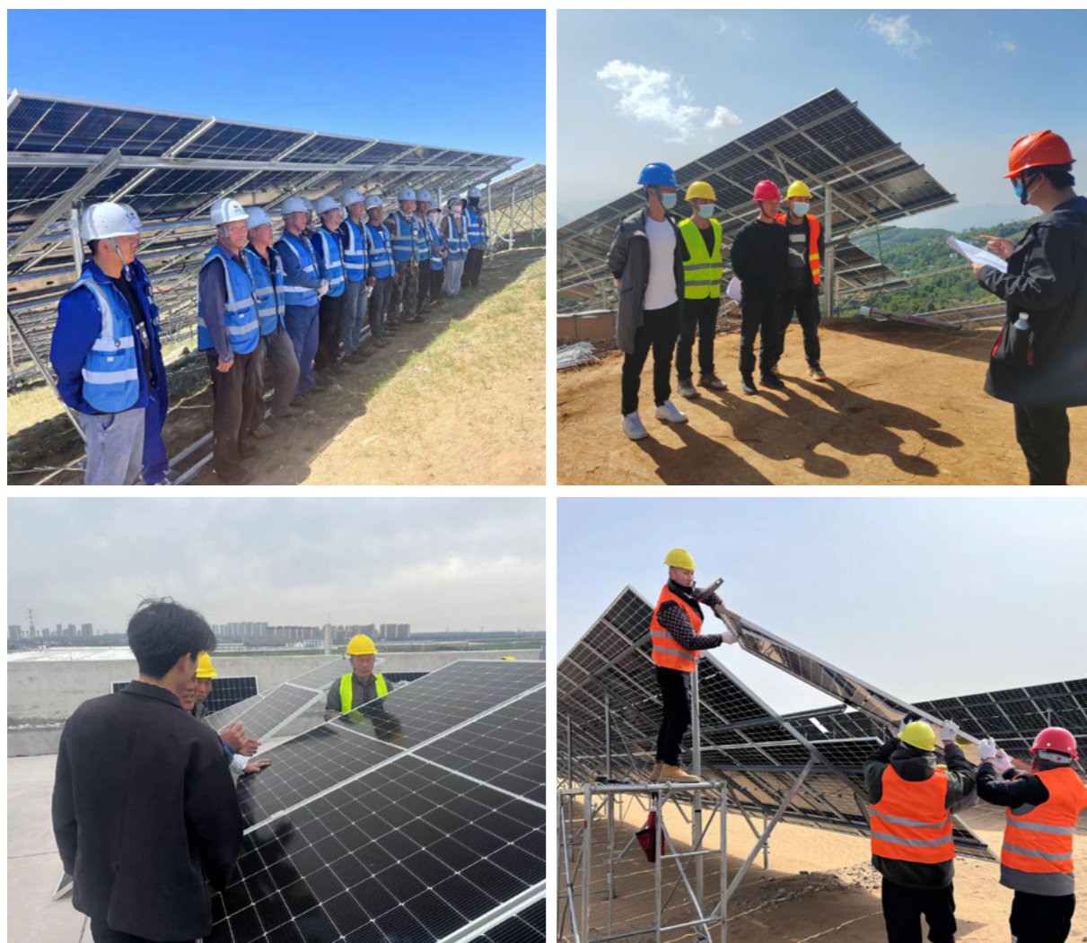
项目施工现场指导
