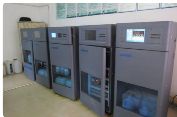
深度废水处理系统水质在线监测系统
