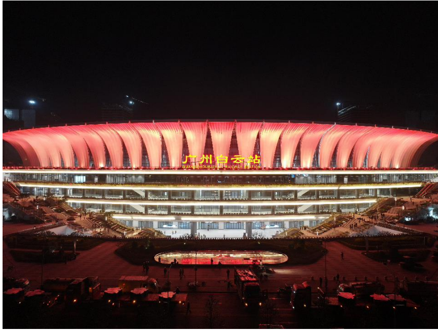
图/报告期内公司完成的广州白云站照明工程项目
