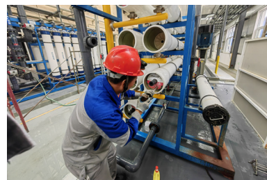
更换反渗透膜实操
