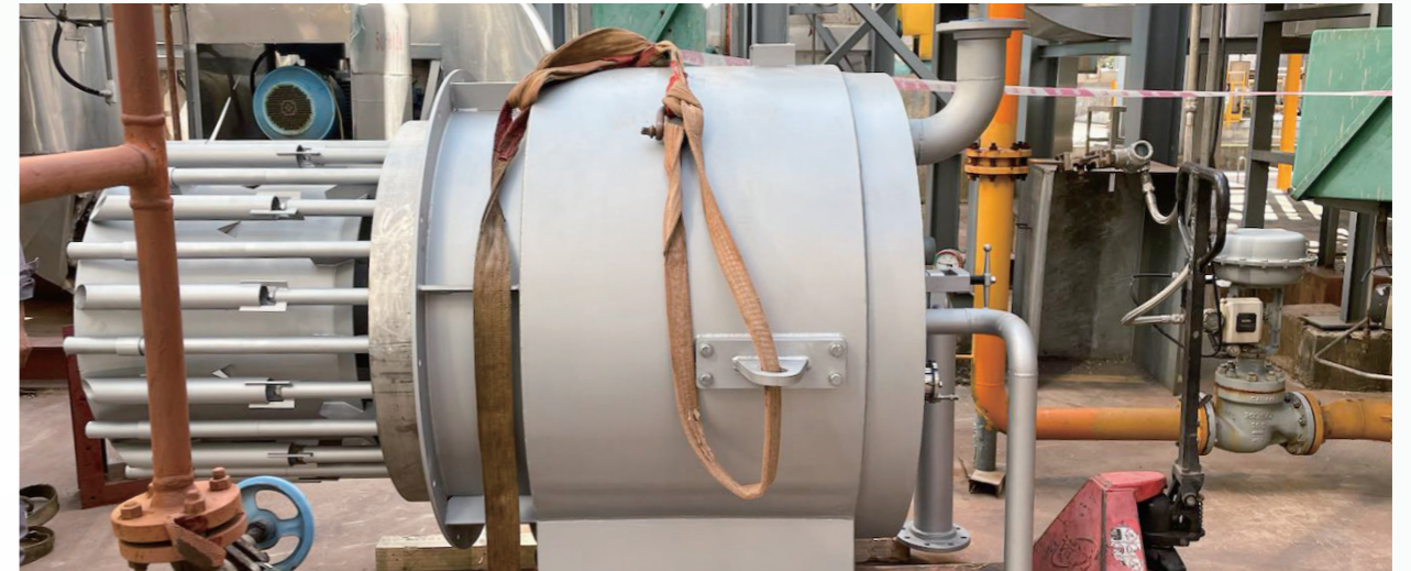
> 燃气热媒炉低氮改造项目
