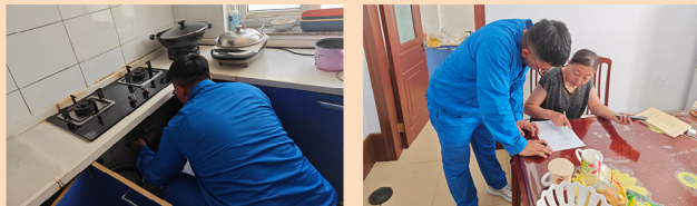
入户开展燃气安全隐患专项排查
