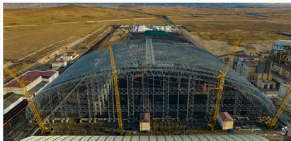
上都发电厂稳步推进煤场封闭工作
