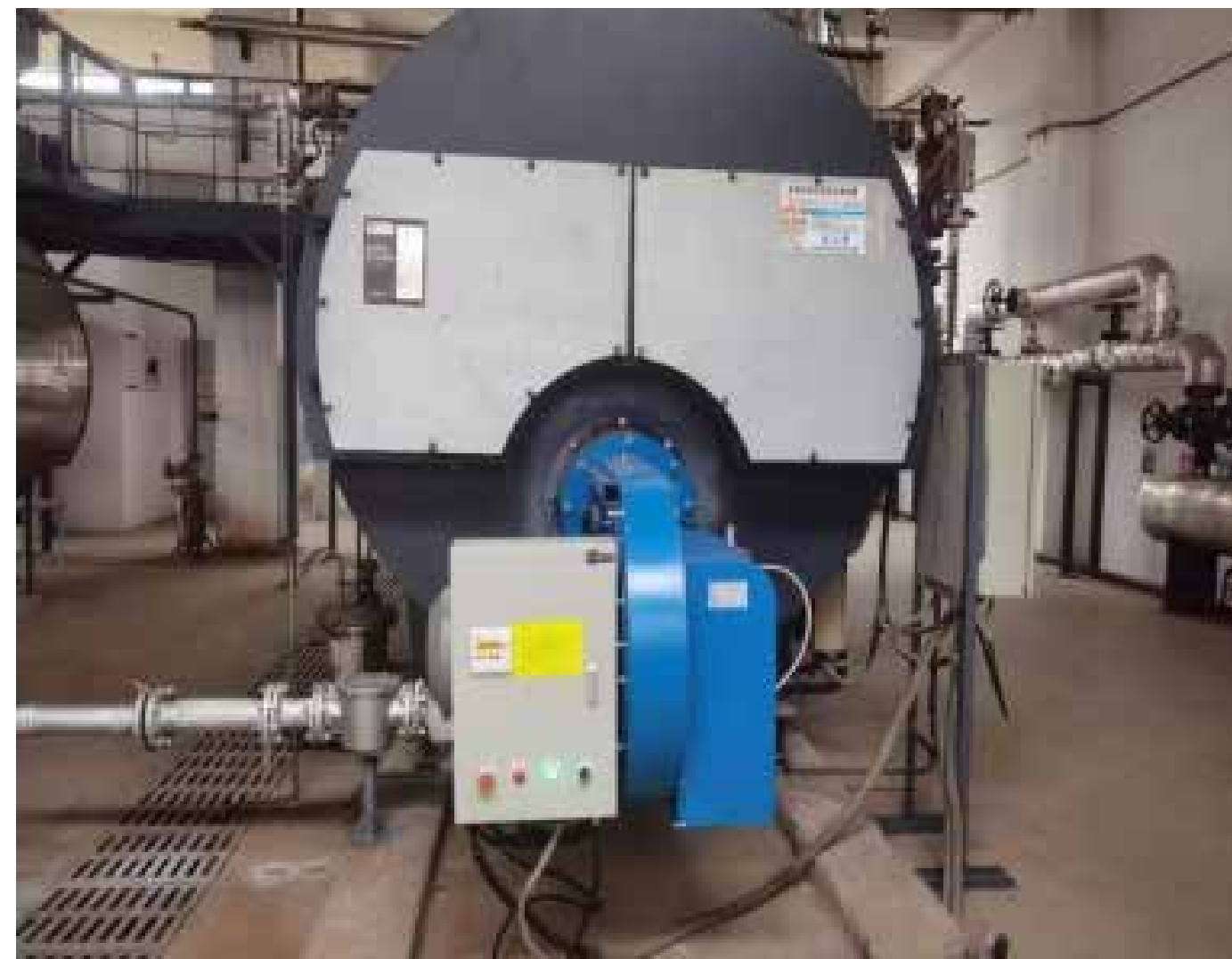
为实现锅炉的低氮排放，公司于2023年12月对两台锅炉进行了低氮燃烧改造，达到超低排放。
