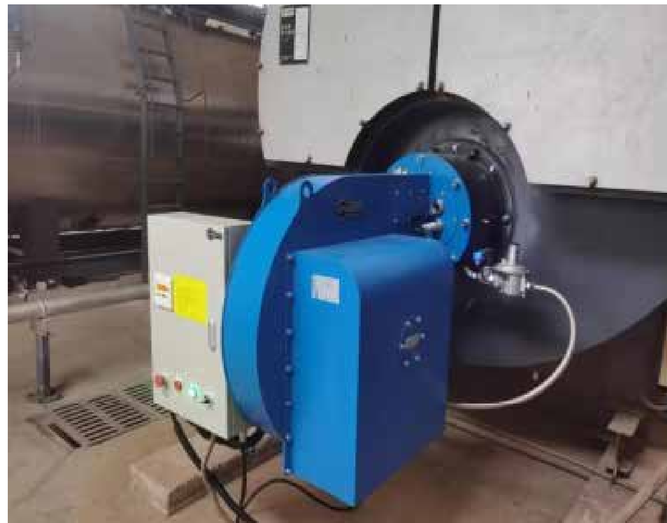
为实现锅炉的低氮排放，公司于2023年12月对两台锅炉进行了低氮燃烧改造，达到超低排放。
