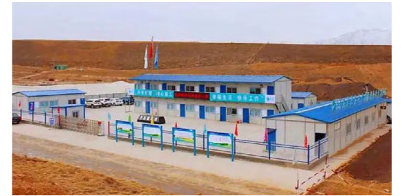
原民乐铬盐厂旧厂区铬污染场地及铬渣场土壤修复项目
