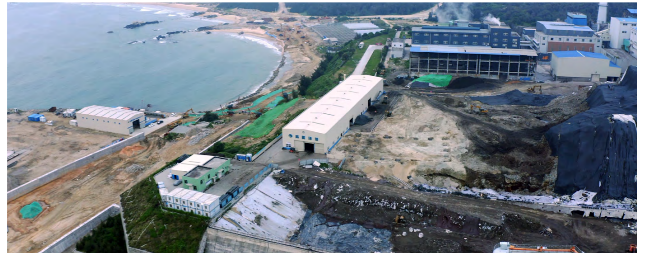
石狮市将军山垃圾填埋场存量垃圾治理项目
