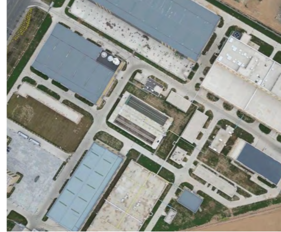
宁东鸳鸯湖污水处理厂扩建工程实现高盐废水零排放
