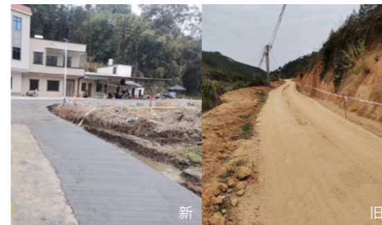
▲ 道路修建新旧对比（修建完后整体拓宽2米）
