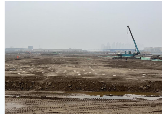
填高施工现场
