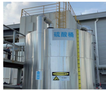
盐城科技设置硫酸加药装置进行酸吸收
