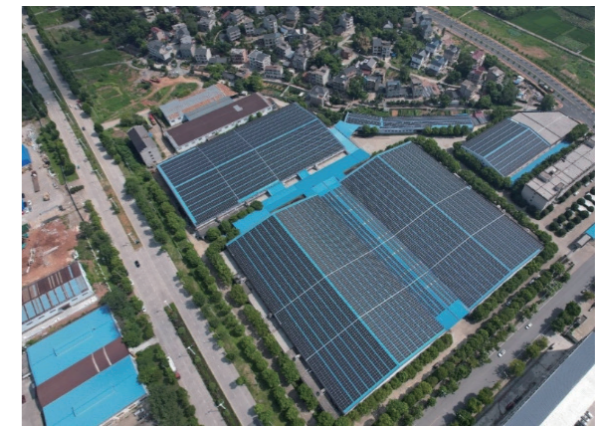
江西上饶德隆纺织有限公司屋顶光伏项目
