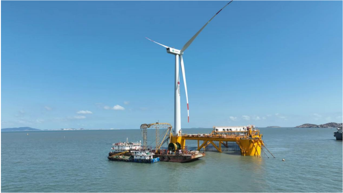
图：全球首个漂浮式风渔融合项目“国能共享号”动态海底电缆施工现场
