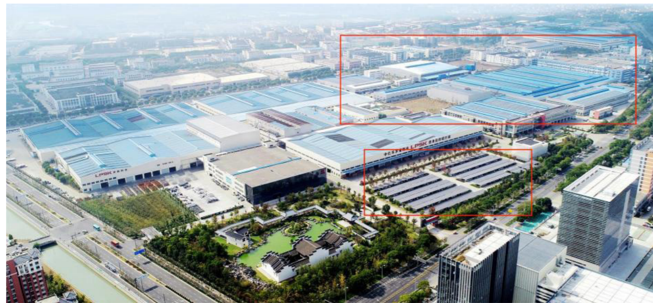
分散式光伏建设
