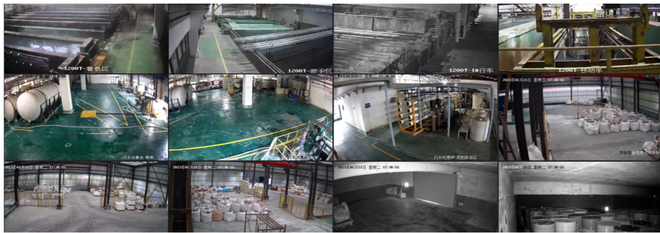
危废仓库、氧化线、污水处理区全部联网至环保局
