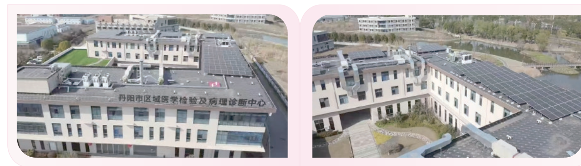
▲ 丹阳兰卫屋顶分布式光伏发电项目
