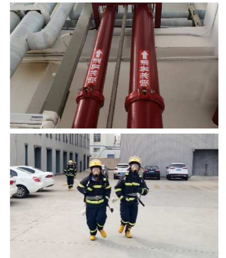
消防安全管理
