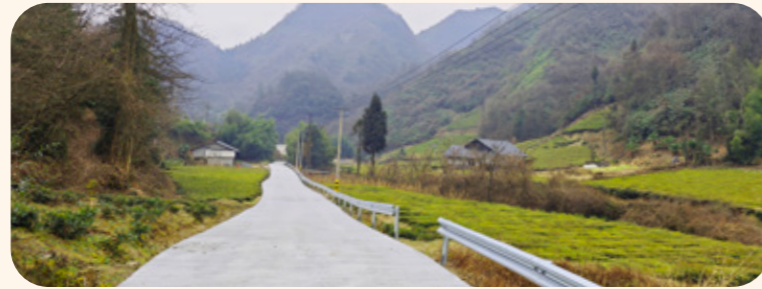
修复后的北镇村道路
