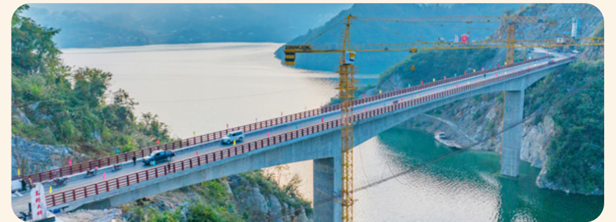
建成通车后的高桥大桥
