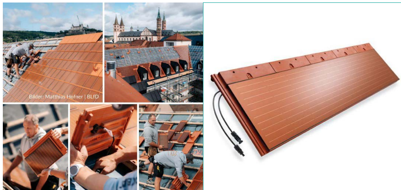
秀强 BIPV 光伏建筑一体化玻璃面板在国际项目中批量安装应用
