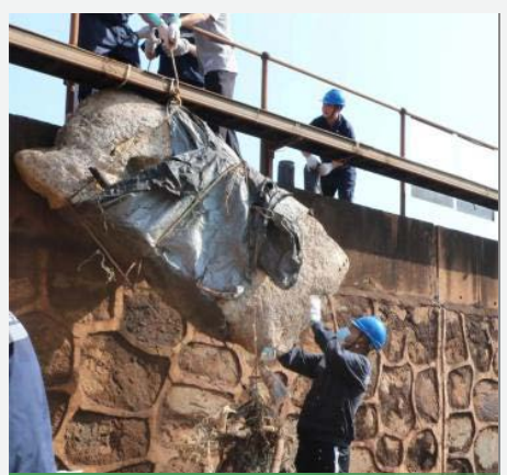
港弘码头海洋垃圾清理活动现场
