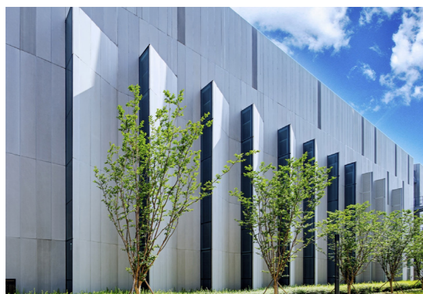
安装完成后的 ECP 板外墙
