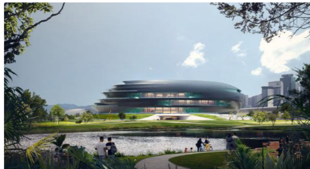
深圳市科技馆 (新馆)
