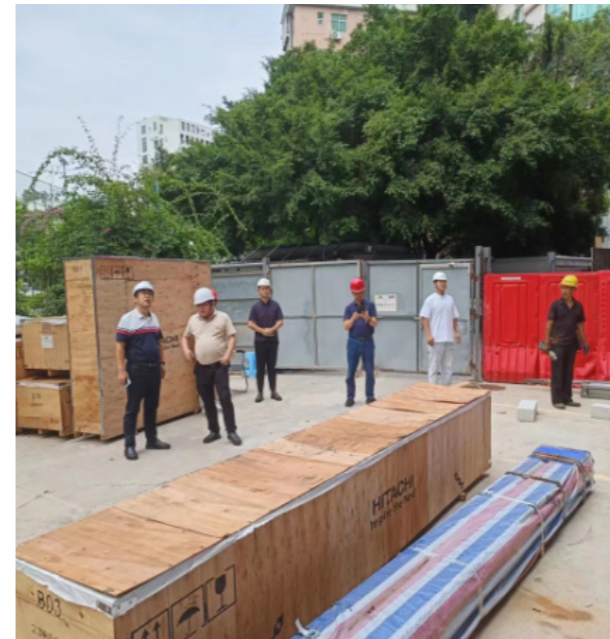
西丽派出所升级改造工程
