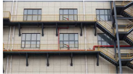
萃取车间室外走廊及应急疏散楼梯
