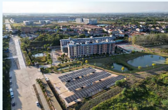
格林美武汉园区停车场光伏车棚
