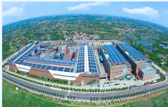
格林美武汉园区厂区屋顶光伏
