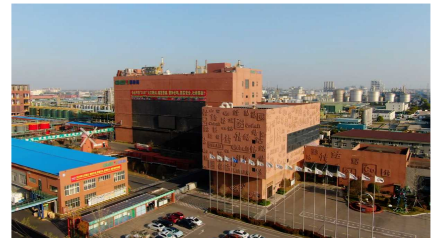
泰兴园区火灾原址修安环广场
