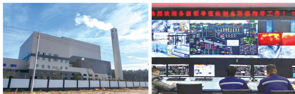
» 生活垃圾焚烧发电项目
