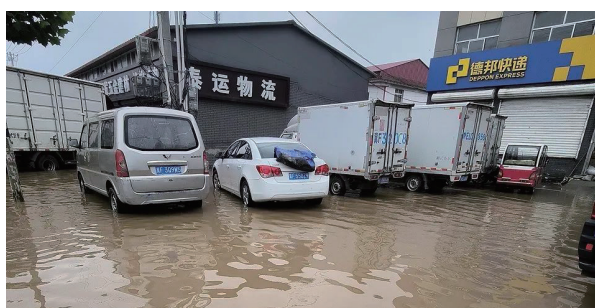
德邦仓库外积水情况
