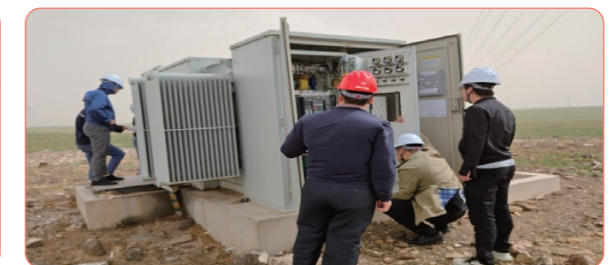
鑫昇哈夏风电场安全检查
