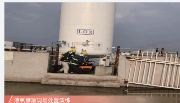
液氧储罐现场处置演练
