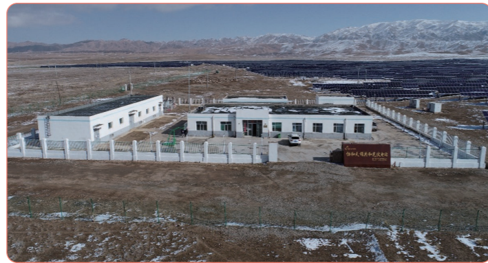
● 海南藏族自治州共和县甘地乡“协和天颂共和光伏电站”
