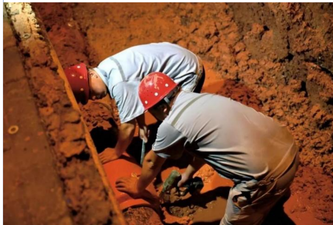
供水设施建设
