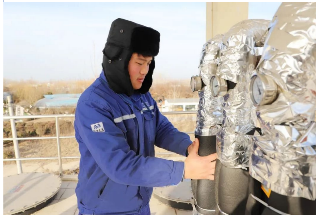
管网设施巡查
