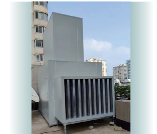
• 精密空调室外机隔音降噪改造后
