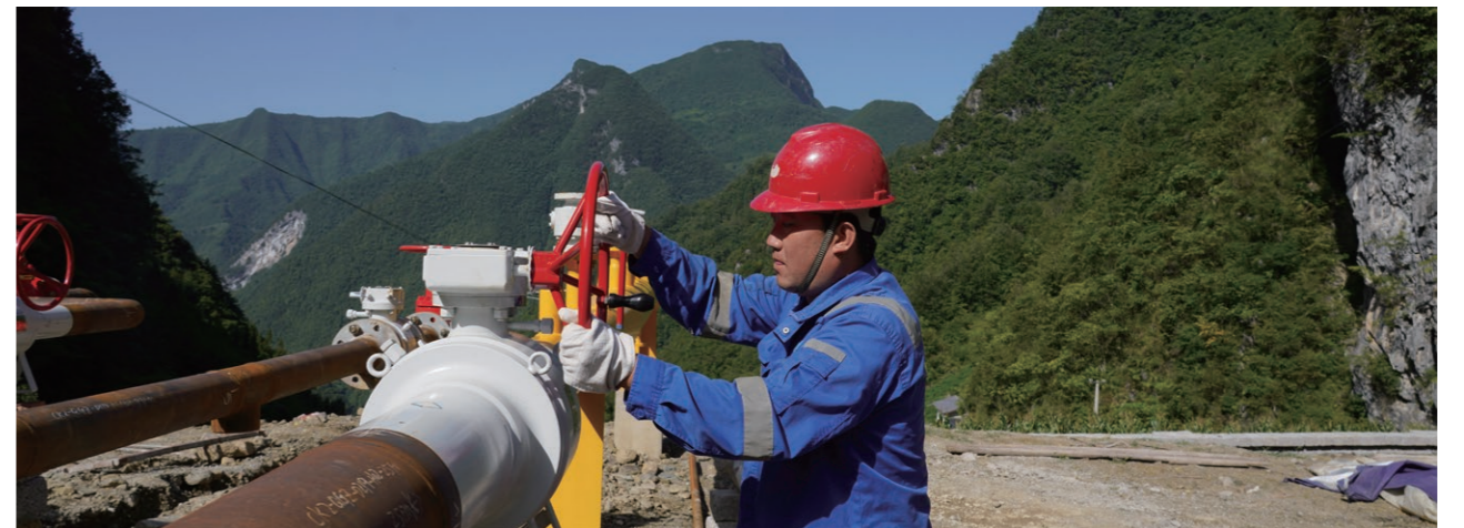
施工人员在海拔 1000 多米的站场安装燃气设备
