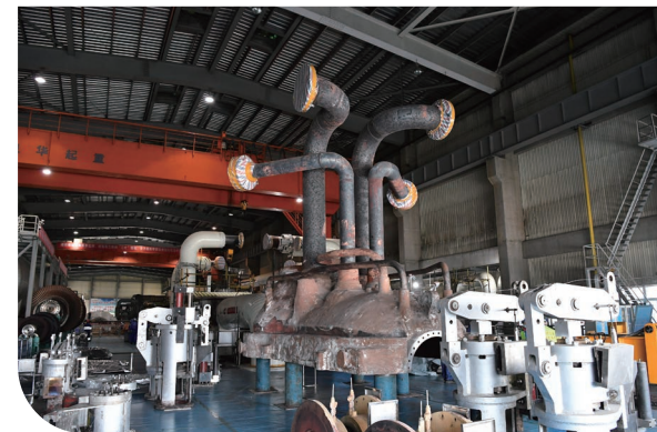
白城发电公司汽轮机通流改造项目
