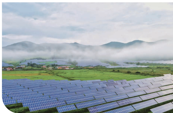
汪清70MW平价光伏发电项目
