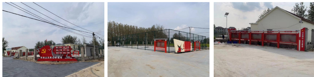
淮安延年村乡村振兴项目
