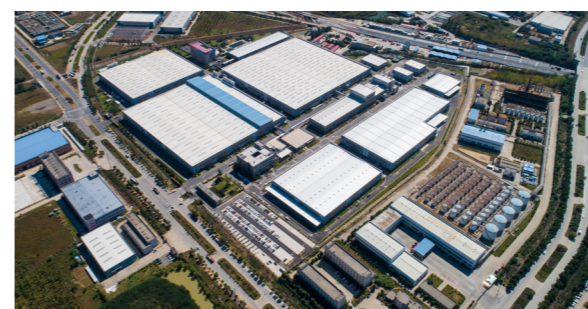
滁州综合智能制造基地，占地 381 亩
