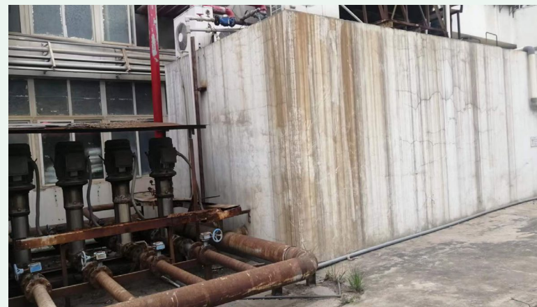
▲ 装配试水循环水池
